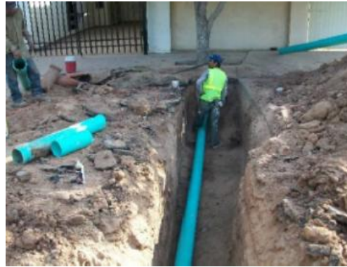
Línea de alcantarillado en la colonia Prohogar (Fase II)
