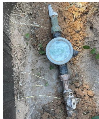
Medidor de agua ultrasónico
