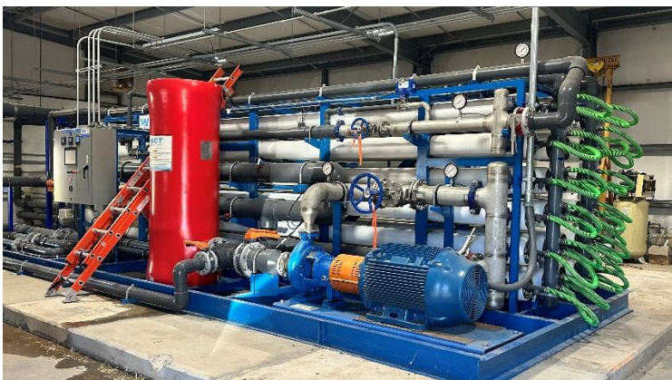
Sistema de tratamiento de ósmosis inversa
