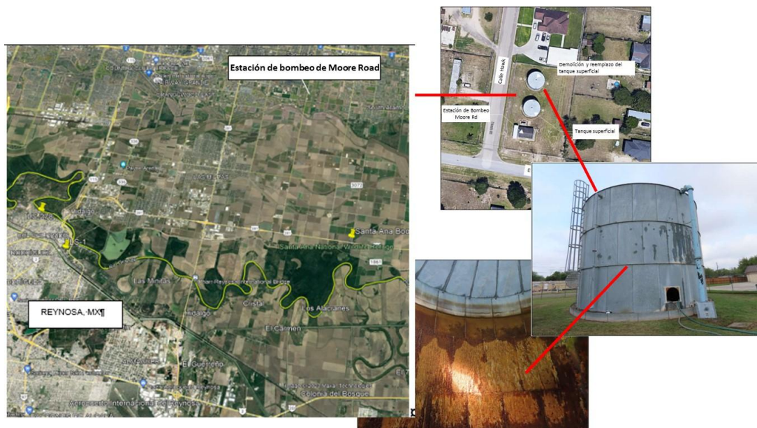
Figura 3 ESTACIÓN DE BOMBEO DE MOORE RD
